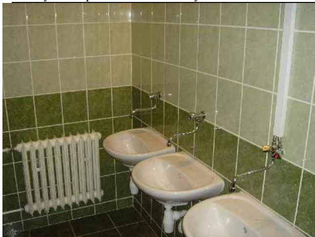
Rekonstrukce sociál. zařízení
