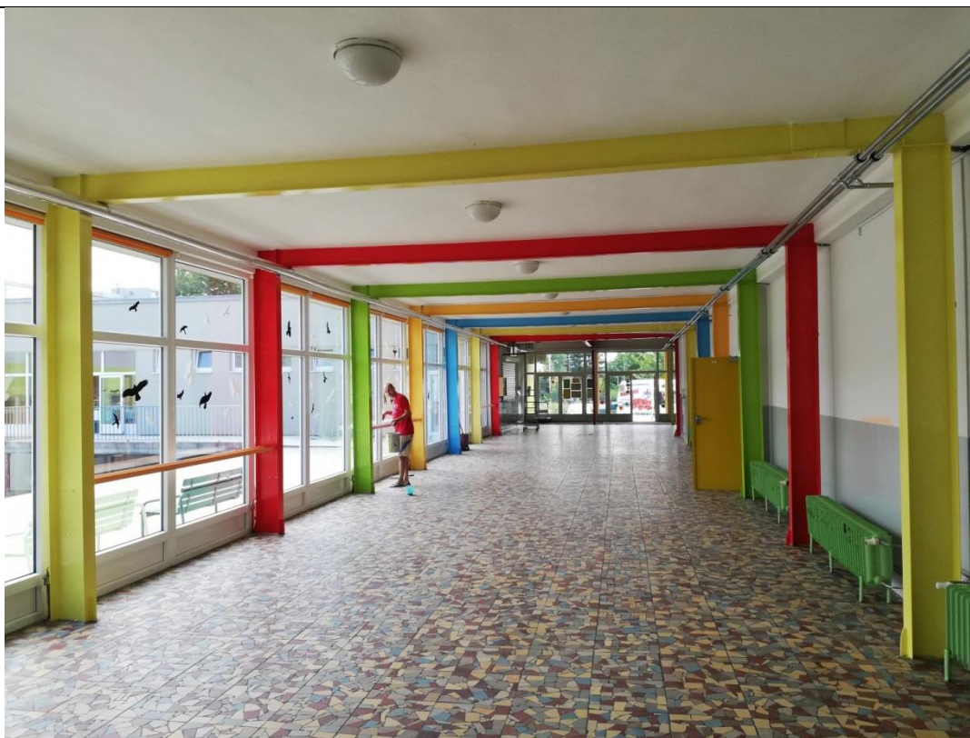
Malířské a stavební práce o prázdninách
